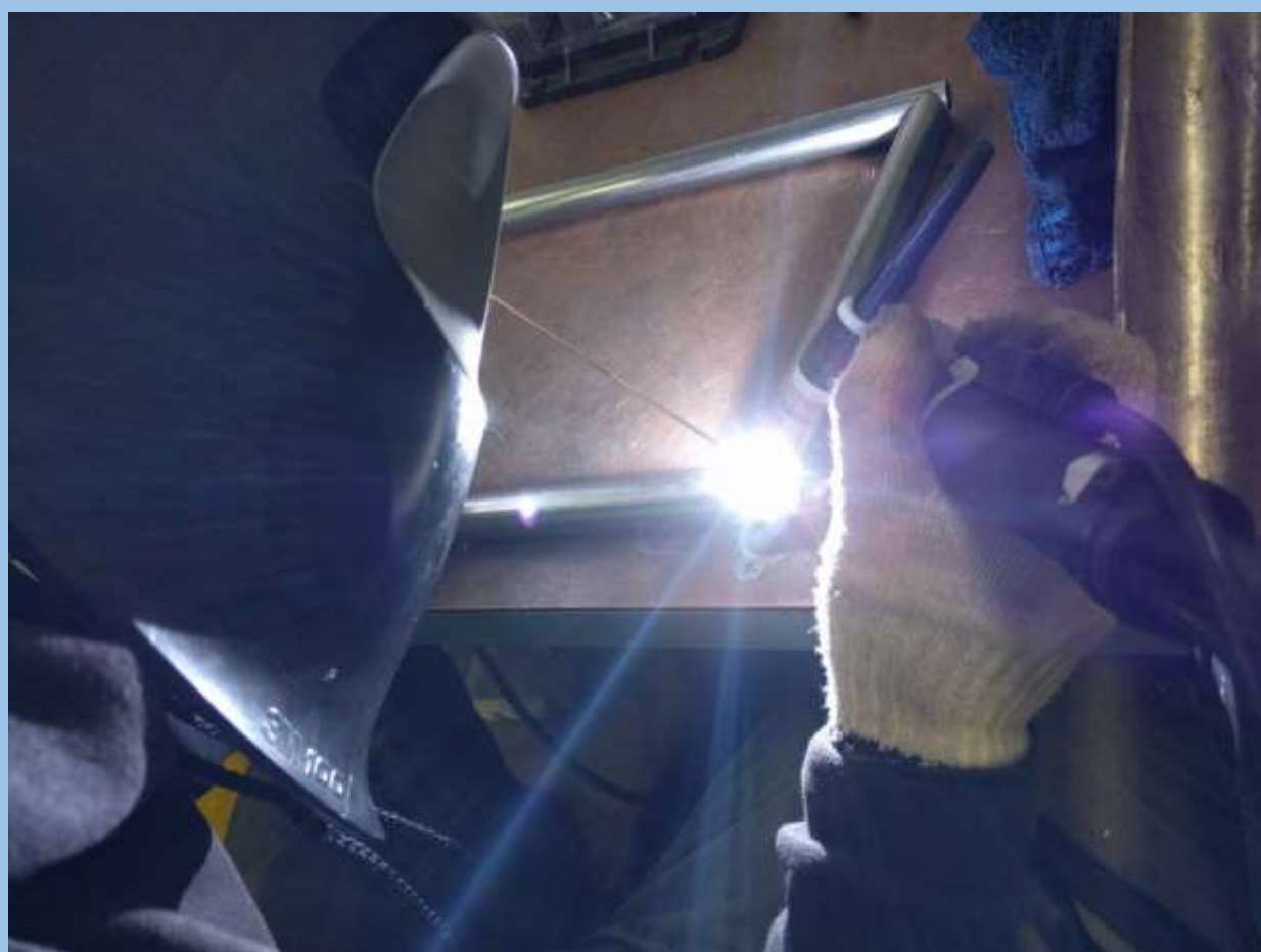
フレームパイプの溶接の様子
