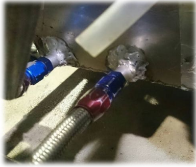
図 13. 燃料タンクの修繕後
