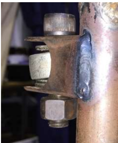
図 1 アームステイの溶接
